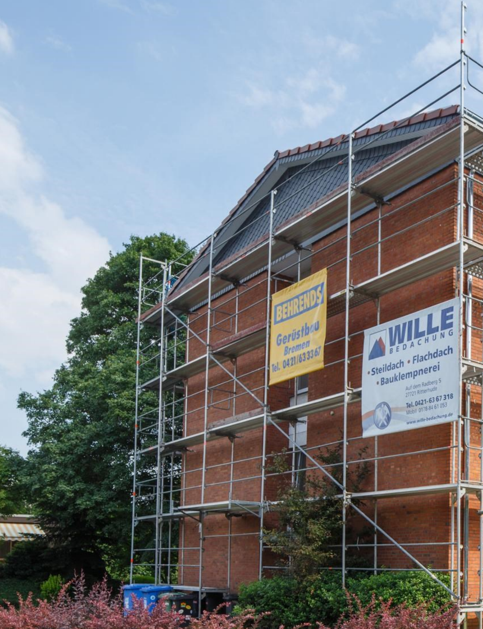
Die energetisch-technische Sanierung im Henne-Haus dauerte insgesamt 6 Wochen. Lediglich für zwei Stunden
