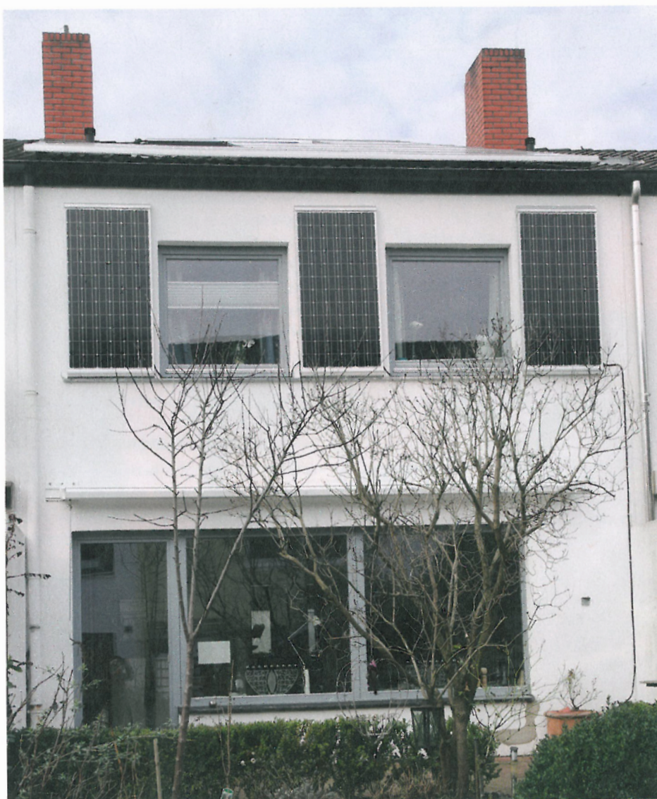
An der Südfassade nutzt Familie Goltsche sogenannte Plug-in-Module für die Steckdose.
